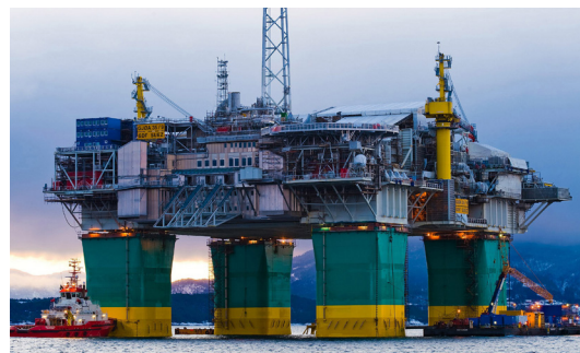
Die Förderung des Gjøa-Feldes vor Norwegens Westküste hat Ende 2010 begonnen. Die Feuerlöschpumpen werden von vier 20-Zylinder-Motoren der MTU-Baureihe 4000 angetrieben.
