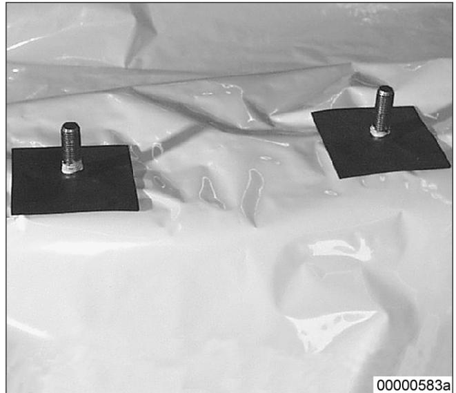
7. Zum zusätzlichen Schutz der Aluminiumverbundfolie auf die Hartgummiplatten Schaumfolie auflegen.
